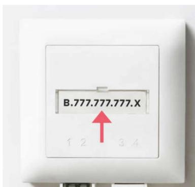
Figure 17 : étiquetage conforme de l'OTO
