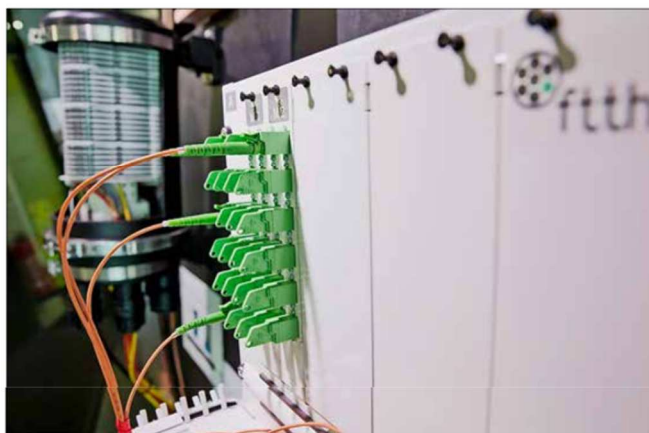
Actuellement, 60 000 des 150 000 ménages fribourgeois peuvent directement se connecter à la fibre optique. ARCH - R. GAPPY
